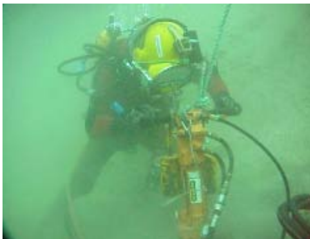
Figur 7 Boring av boltehull. Foto: Namsos dykkeselskap
